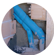
Esempio di un cavedio dove all'interno vi è uno scarico coibentato con Sonik.
