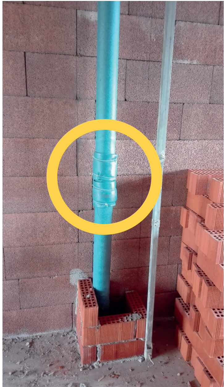
Unione tra i due isolanti acustici SONIK, fondamentale per il giusto isolamento, il nastro SONIK fissato con due fascette.
