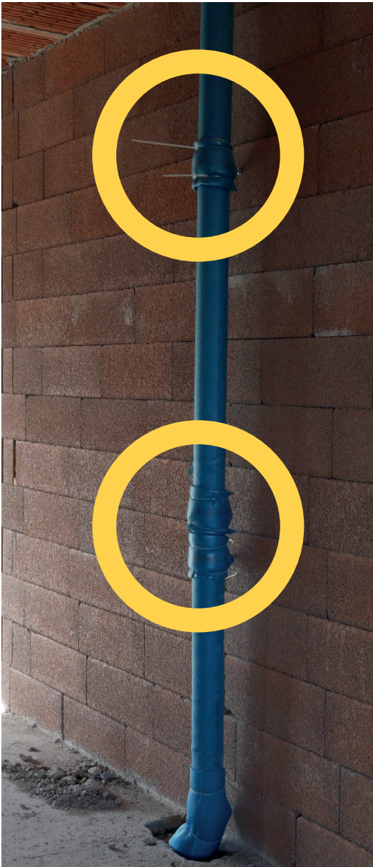
Unione tra i due isolanti acustici SONIK, fondamentale per il giusto isolamento, il nastro SONIK fissato con due fascette.
