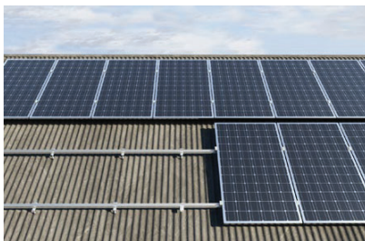
Copertura inclinata con rivestimento in lastre ondulate
