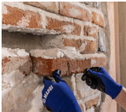
Ricostruzione di muratura in mattoni
