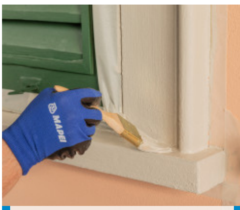
Finitura colorata di un elemento costruttivo
