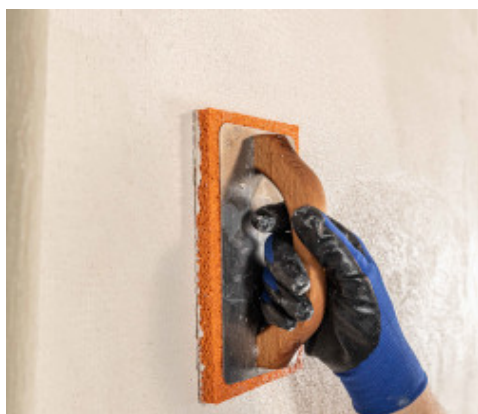
Finitura con frattazzino di spugna
