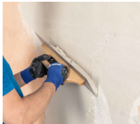
Rasatura di supporti esistenti
