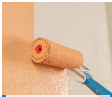
Pittura dei supporti ricostruiti con Mape-Antique NHL ECO Restaura
