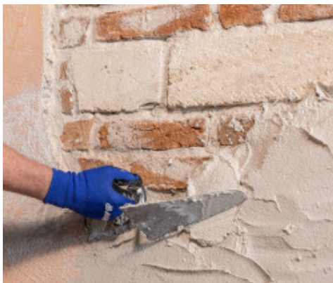
Livellamento e ricostruzione degli intonaci
