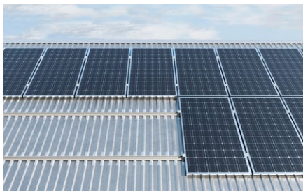
Copertura inclinata con rivestimento in lamiera grecata.
