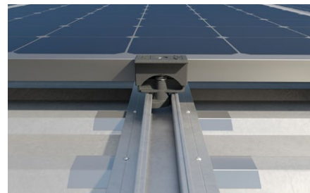
Copertura con rivestimento in lamiera grecata.
